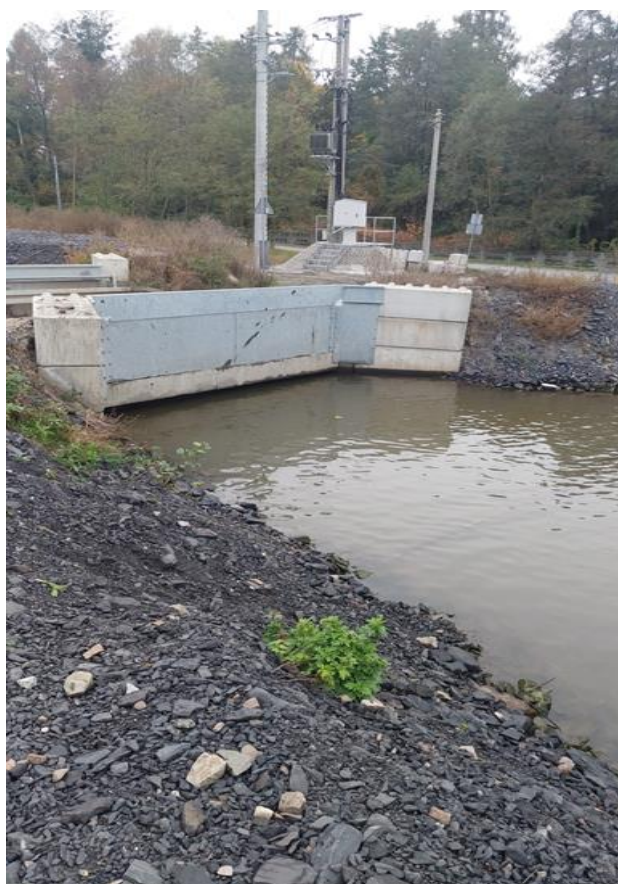
ZDJĘCIE 2 PRZEPUST NA NACYNIE UL. MACZKA
