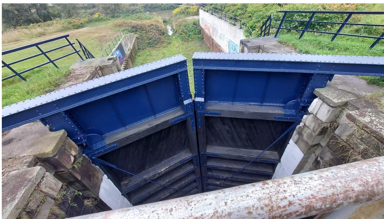
ZDJĘCIE 1 WROTA WAŁOWE PRZECIWPOWODZIOWE PO REMONCIE
