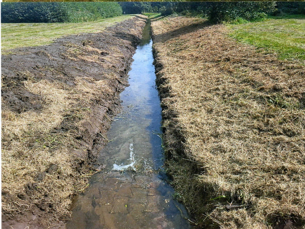
Odcinkowa konserwacja cieku Mszanka w km 0+000 – 4+000.
