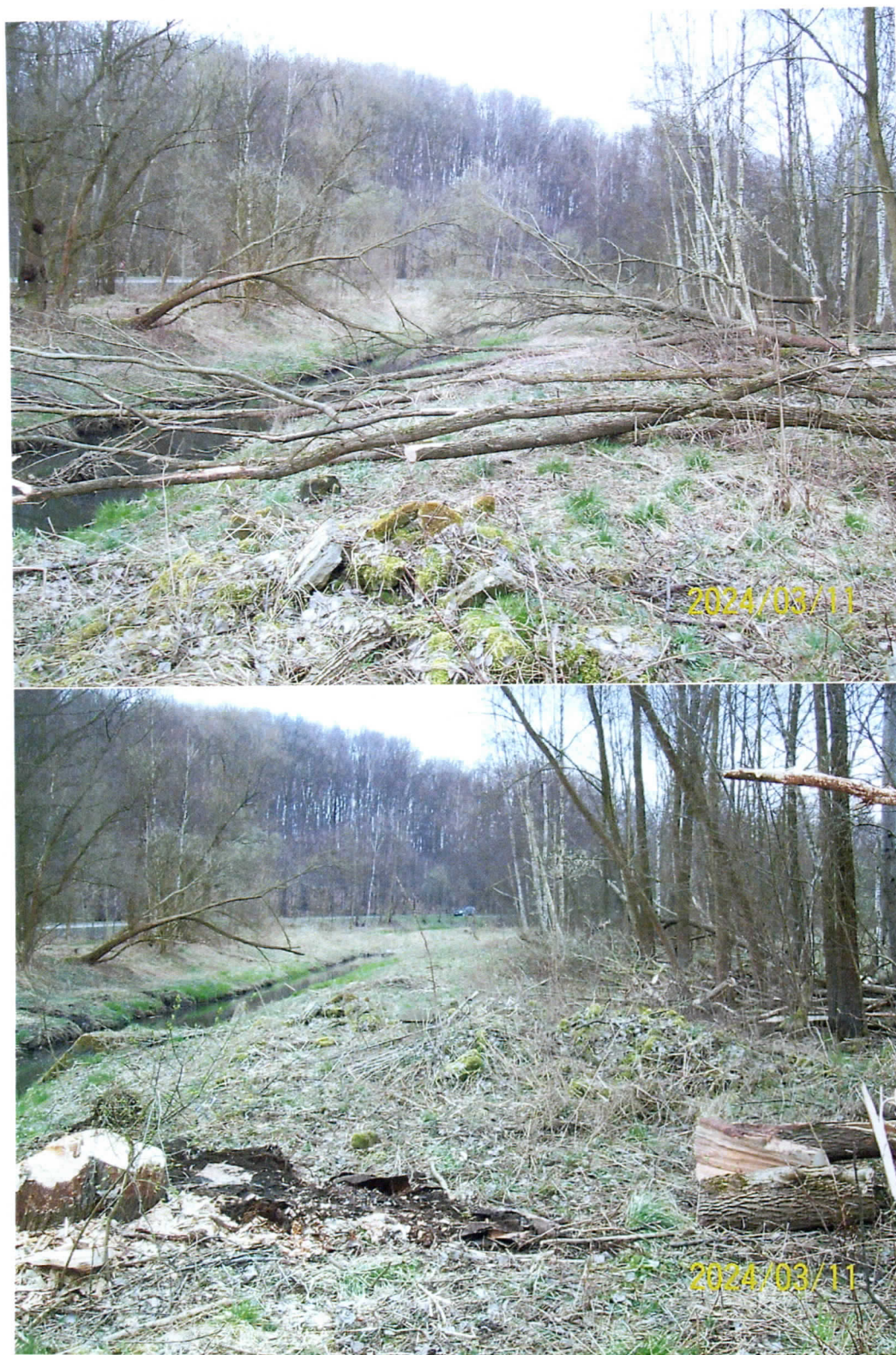
Awaryjne usunięcie tam bobrowych i zatorów z koryta rzeki Leśnica przy ul. Łużyckiej w m. Wodzisław Śląski.
