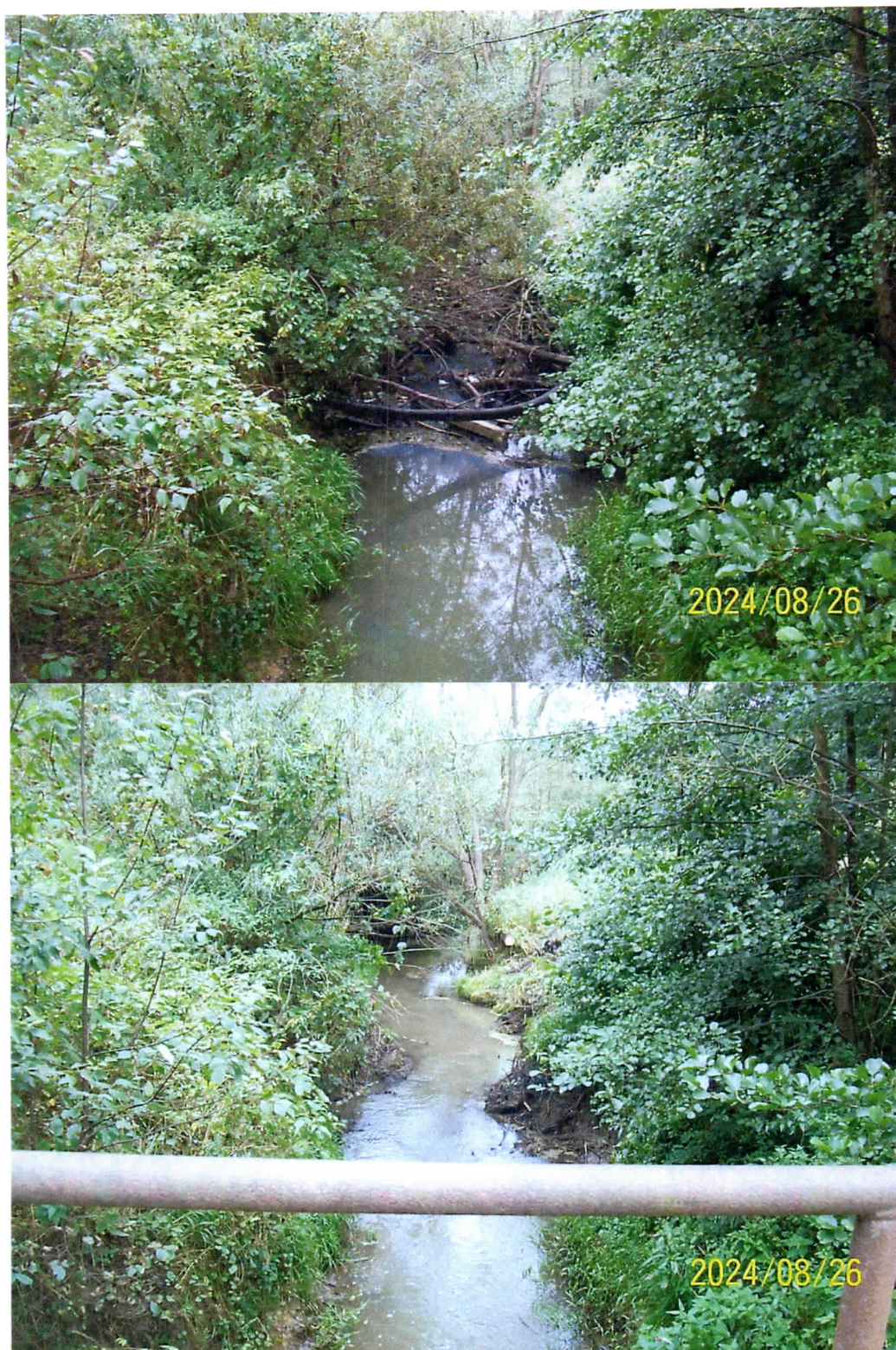
Usunięcie zatoru z koryta rzeki Piotrówki przy ul. Młyńskiej 4 w m. Kończyce Wielkie gm. Hażlach
