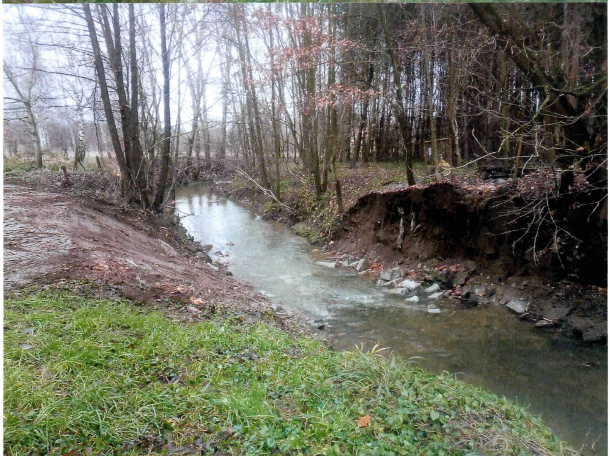
Awaryjne usunięcie kładki dla pieszych na rzece Piotrówka w m. Zebrzydowice stwarzającej zagrożenie dla swobodnego przepływu wód.
