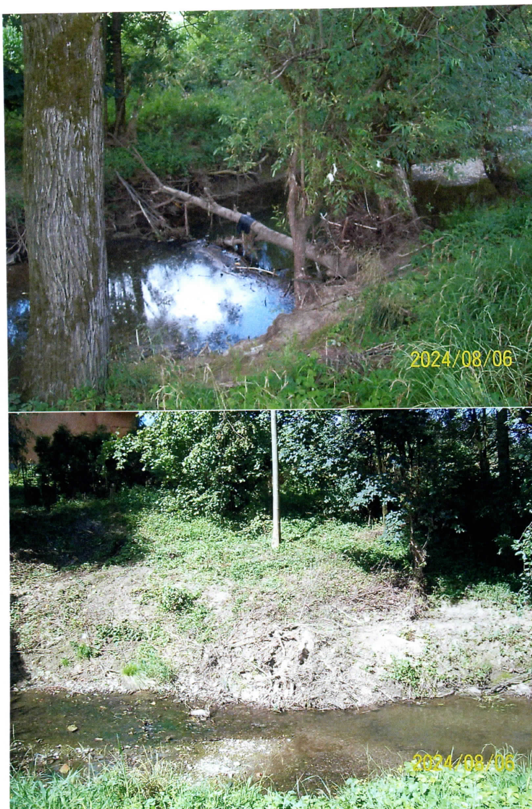
Uprzątnięcie konarów i gałęzi w obrębie koryta rzeki Puńcówki przy ul. Granicznej w m. Dziegiełłów gm. Goleiszów.
