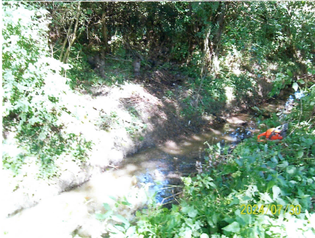
Usunięcie zatoru z koryta cieku Krasna w m. Cieszyn.
