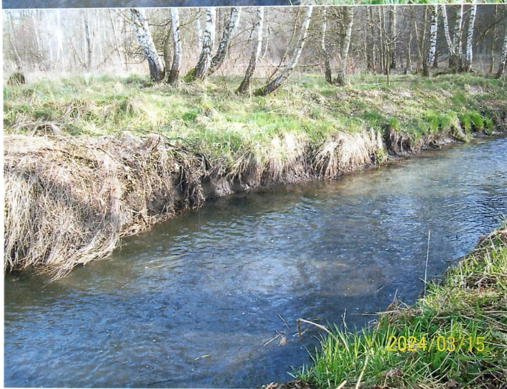
Awaryjne usunięcie tam bobrowych i zatorów z koryta rzeki Leśnica przy ul. Łużyckiej w m. Wodzisław Śląski.
