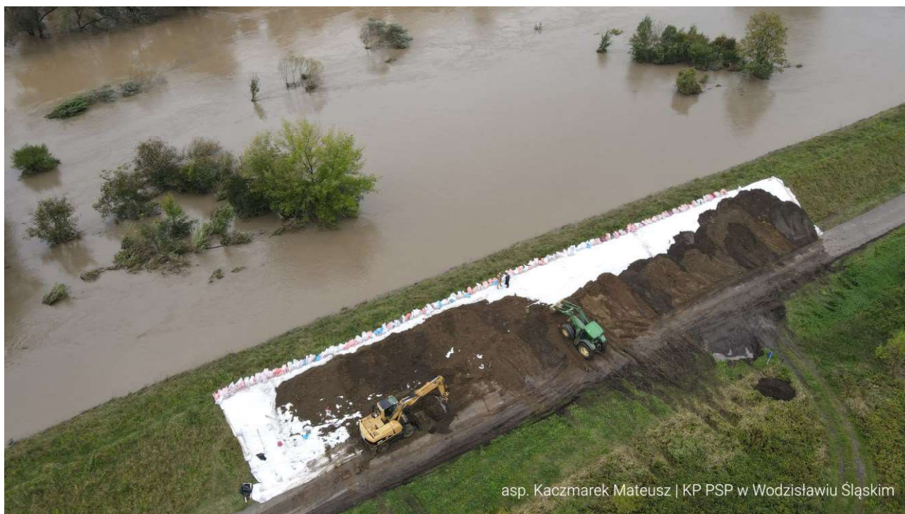
ZDJĘCIE 2 USZCZELNIANIE PRZECIEKAJĄCEGO WAŁU PRZECIWPOWODZIOWEGO W OŁZIE
