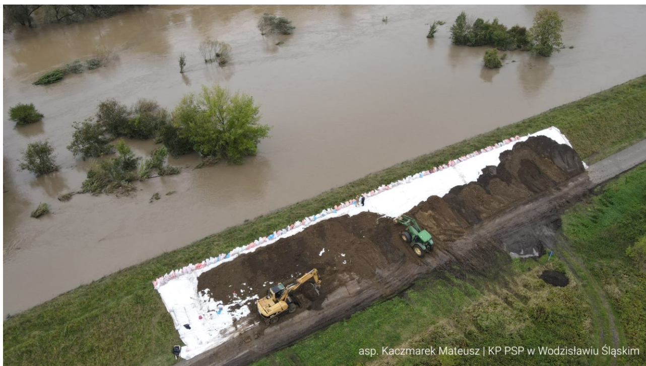
ZDJĘCIE 2 USZCZELNIANIE PRZECIEKAJĄCEGO WAŁU PRZECIWPOWODZIOWEGO W OŁZIE
