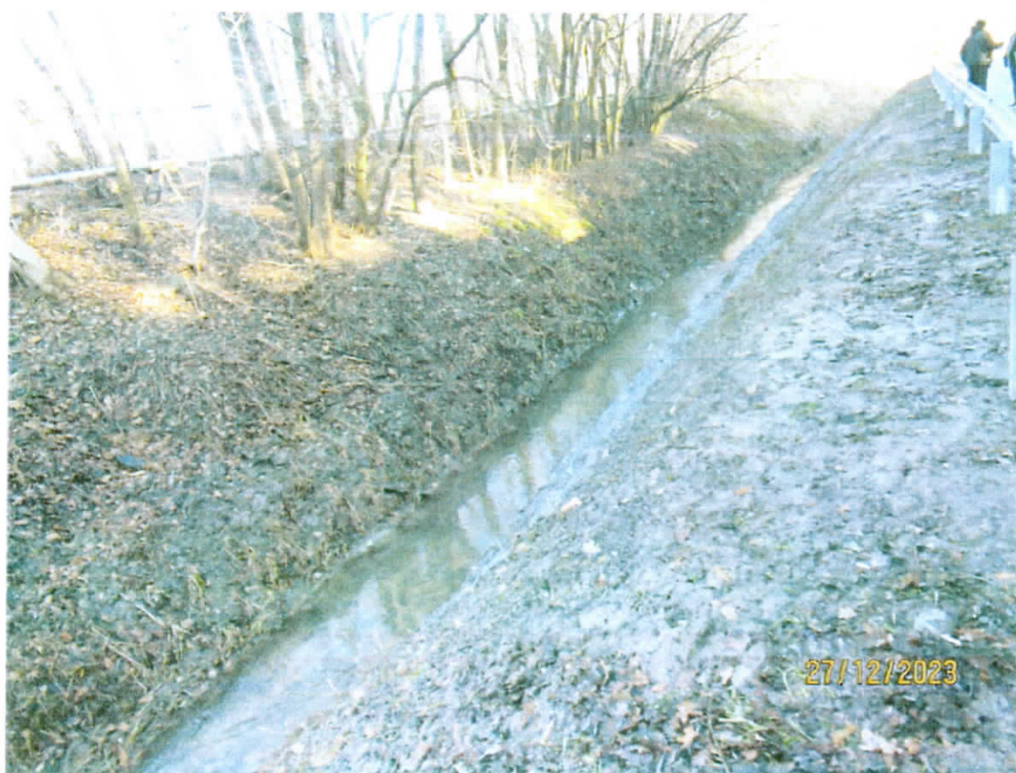
Prace utrzymaniowe na cieku Marklówka przed i po wykonaniu.
