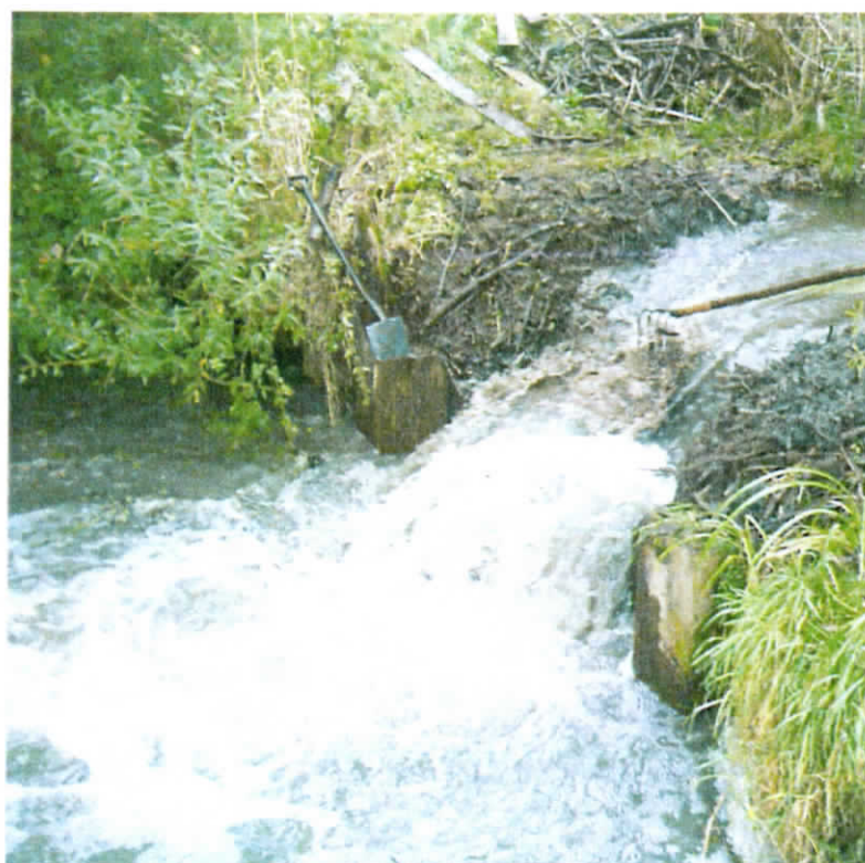
Usunięcie zatoru z koryta cieku Jelonek przed i po usunięciu.
