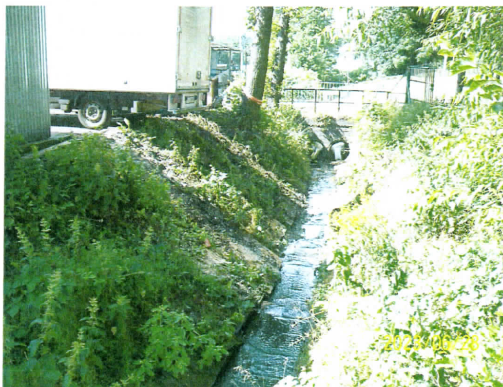
Usunięcie zatoru z koryta cieku Jastrzębianka przed i po.
