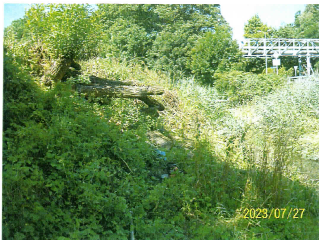
Usunięcie zatoru z koryta cieku Jastrzębianka przed i po usunięciu.
