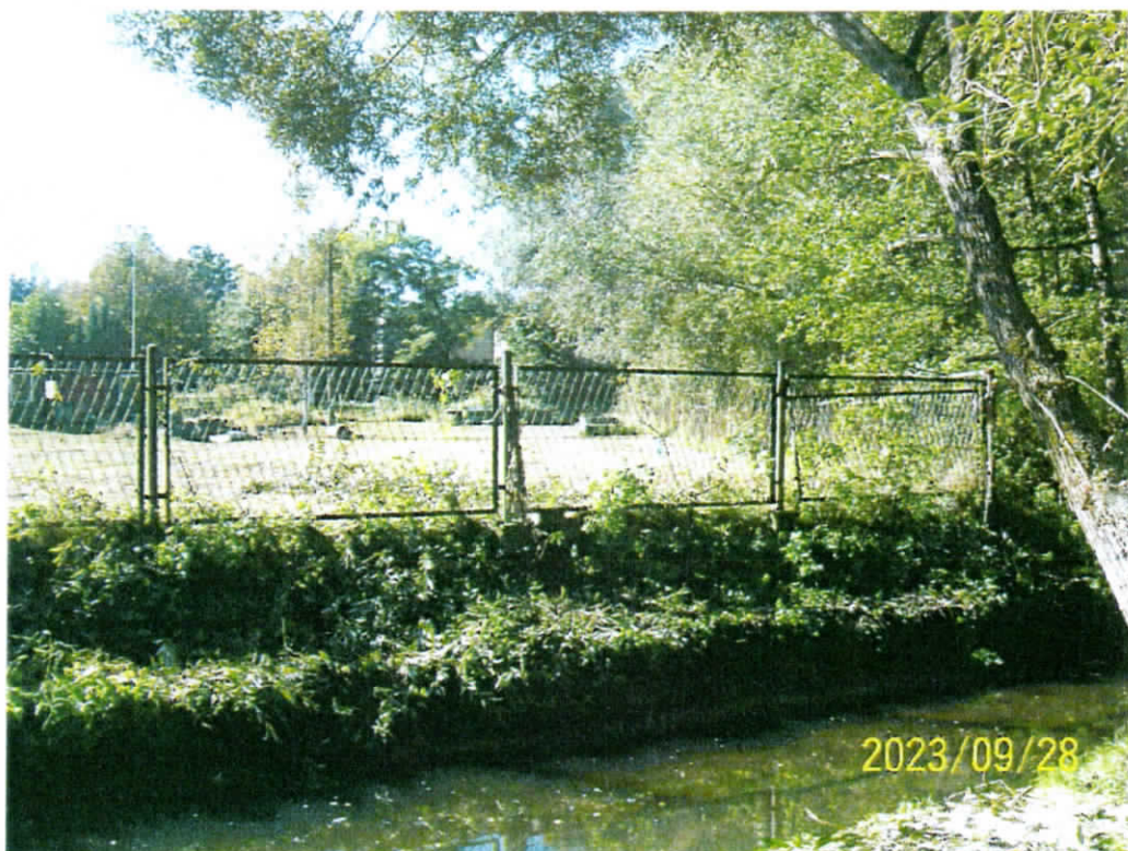
Usunięcie wiatrołomu z cieku Jastrzębianki przed i po usunięciu.
