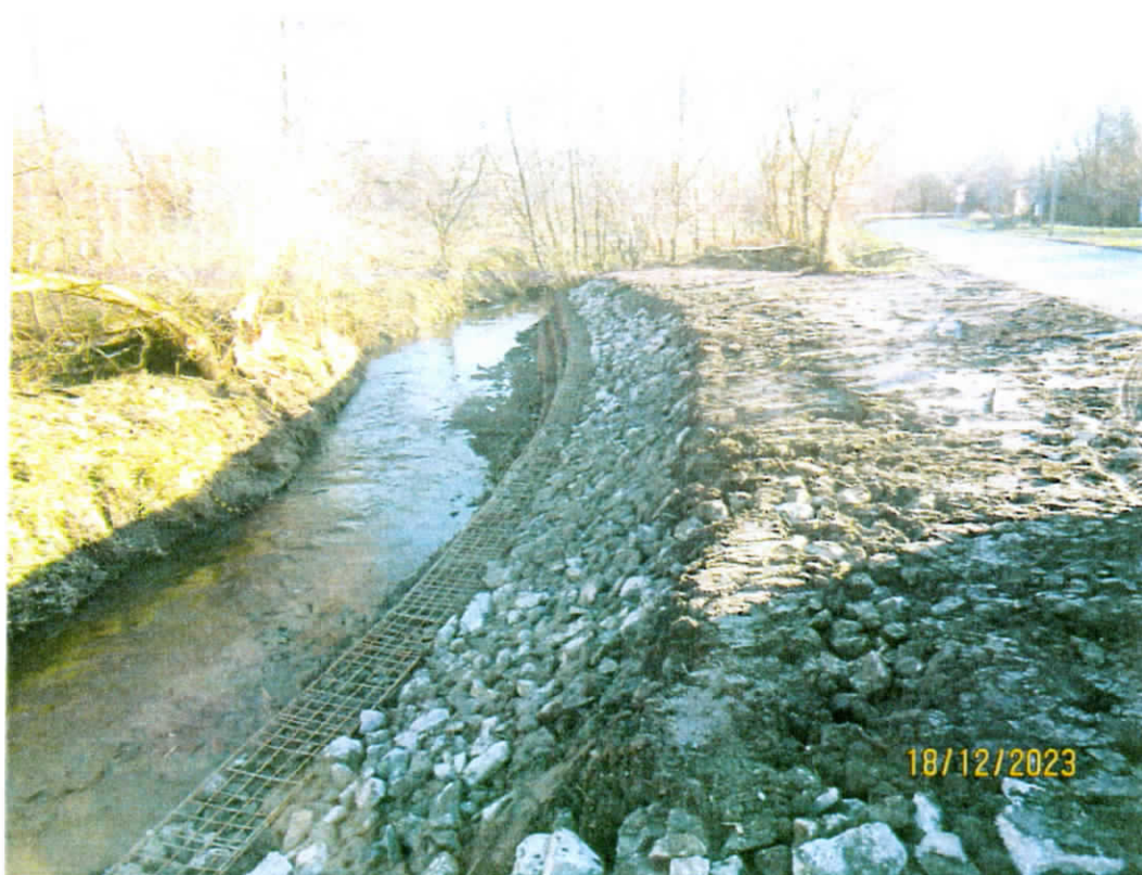
Zabudowa wyrwy w prawym brzegu rzeki Leśnicy przed i po wykonaniu.
